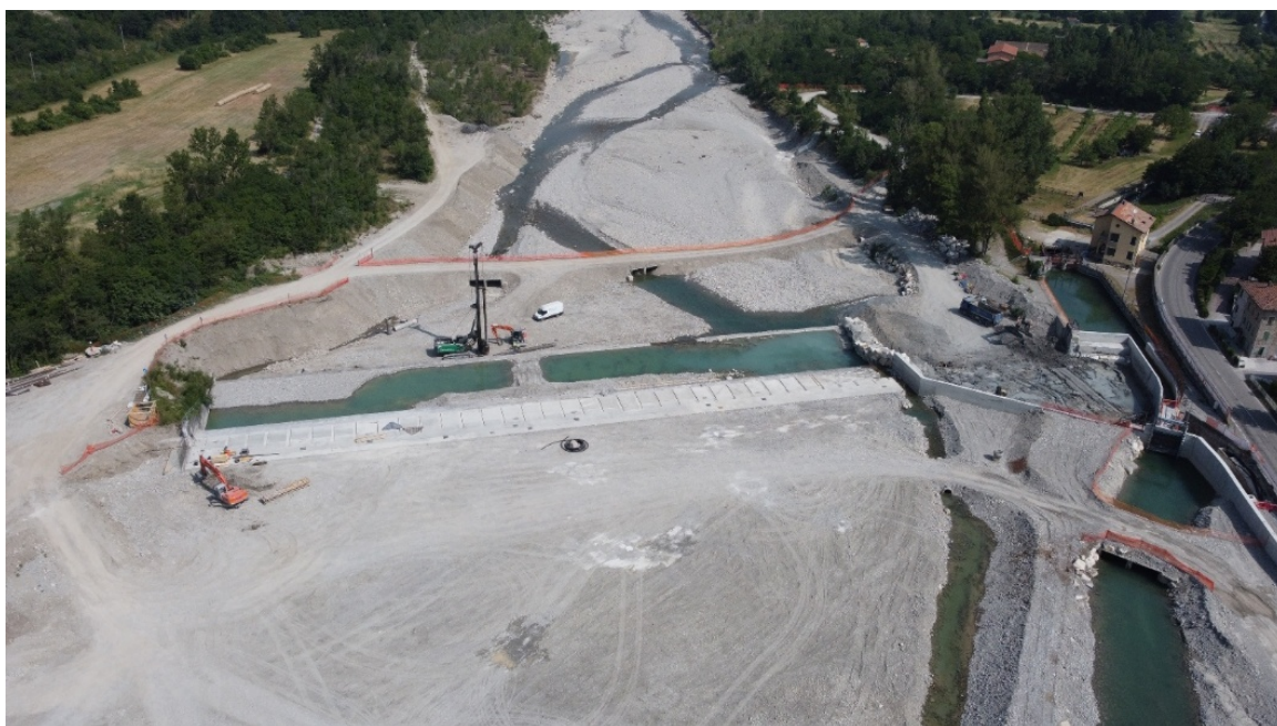
Lavori in corso di riqualificazione della traversa esistente sul torrente Enza in località Cerezzola
